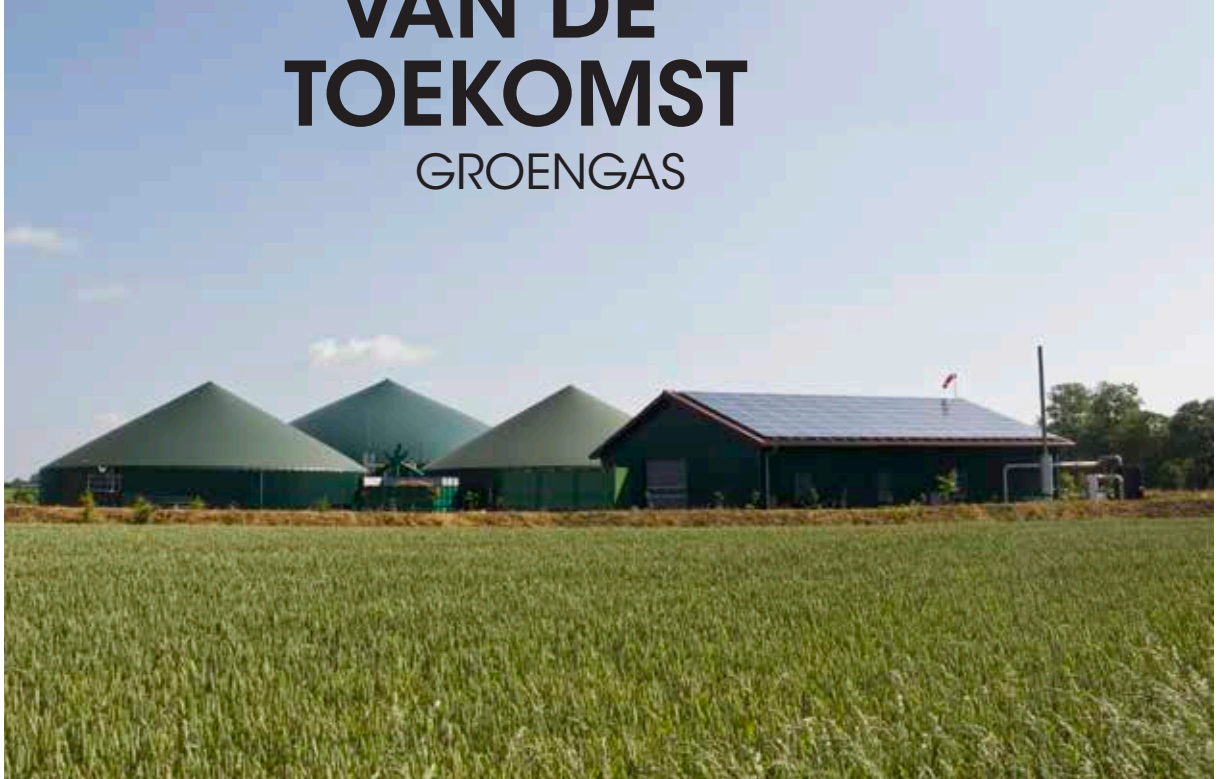
VERGISTINGSINSTALLATIE BIJ EEN BOERDERIJ IN NIEDERSACHSEN
